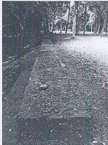
Foto 11. Parapeto Oeste, Calzada Blom
